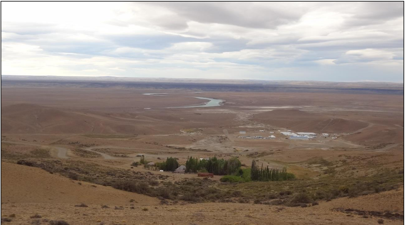
Figura 11-51. Fotografía desde Ruta 9 al norte, se observa la Estancia Rincón Grande (no se encontraron pobladores presentes el día del relevamiento), el Campamento Jorge Cepernic y la zona de la futura presa.
