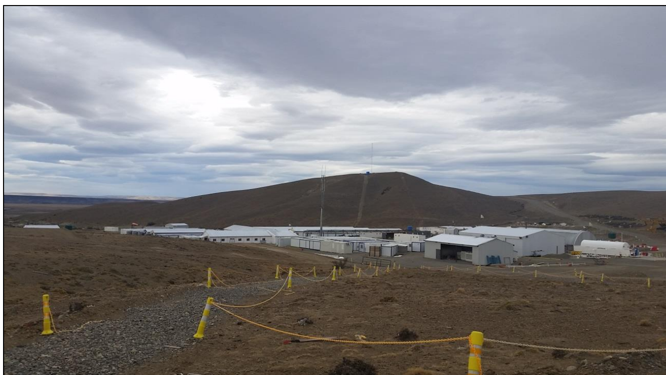
Figura 11-53. Edificaciones en el campamento JC.
